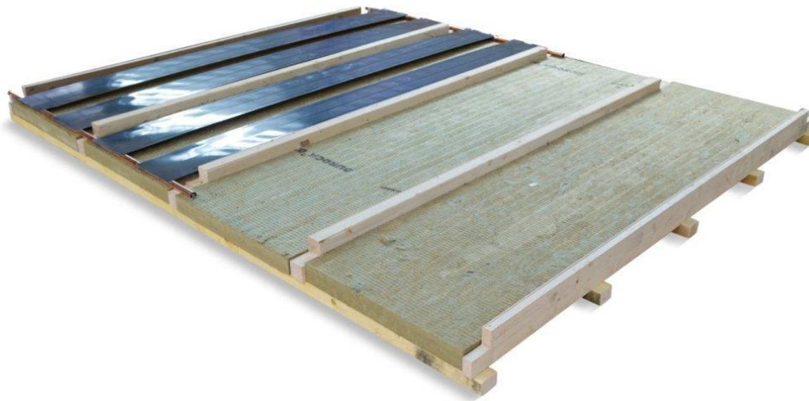
Einlegen und verbinden der Absorber KM 2 mit anschließender Druckprobe.
