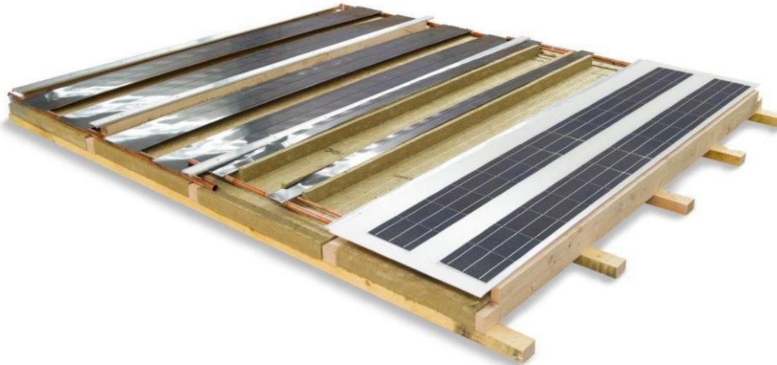
Die PV- Module werden eingelegt und Kabelverbindungen in Freiräume gezogen.
